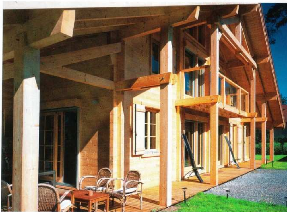
Toute la vie des propriétaires se déroule en rez-de-chaussée, avec une terrasse couverte accolée à la cuisine. Les assemblages d'angles sont caractéristiques des maisons en madrier. Ici, ils ont été sablés et brossés pour accentuer le relief. De 140 mm d'épaisseur, ils suffisent à isoler thermiquement la maison.
