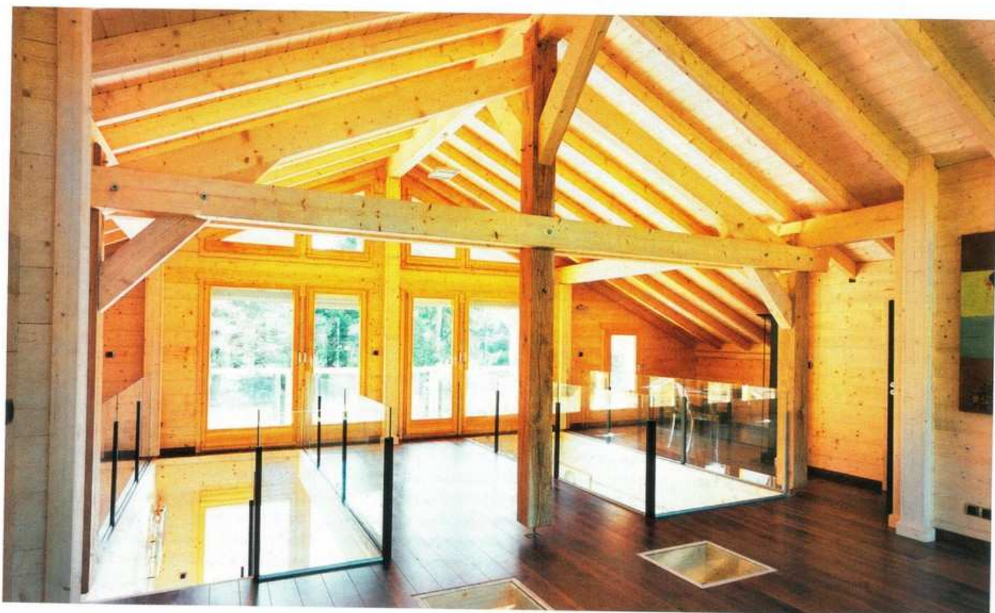
La mezzanine est un vaste espace destiné aux enfants, avec une salle de bains et des dortoirs. Deux grands percements, ceinturés par des garde-corps vitrés et des puits de lumière en verre dans le sol permettent d'apporter beaucoup de luminosité au rez-de-chaussée.
