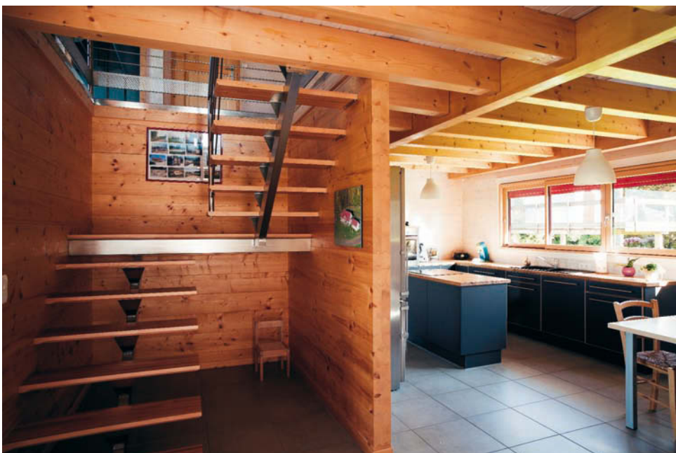
Léger, cet escalier repose sur une structure inox et des marches en hêtre lamellé-collé. C'est autour de lui que tourne toute l'organisation du rez-de-chaussée. C'est l'unique séparation entre les pièces.
